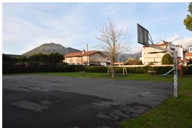
Stato attuale dell'area oggetto della Variante al R.U. (Edificio in località Nazzano)
