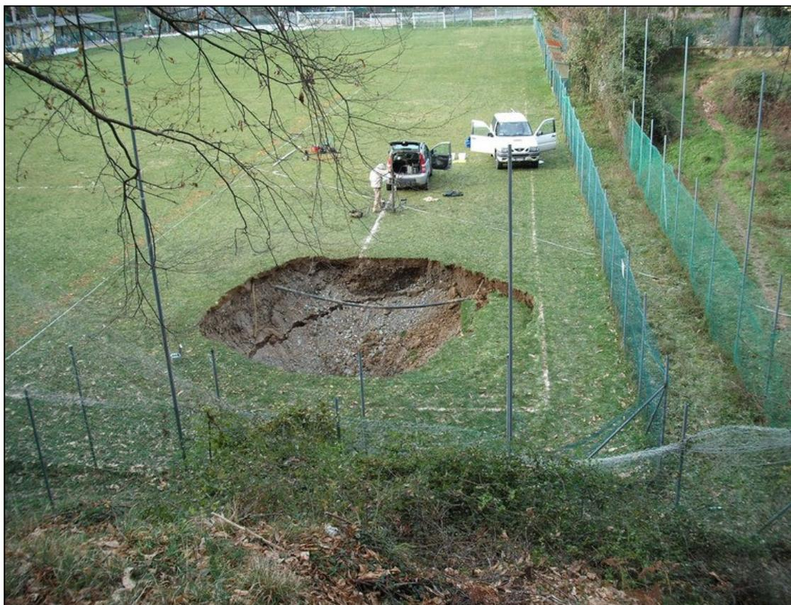
Fig. 3.14. Vista del sinkhole verificatosi c/o il campo sportivo del paese di Bergiola Foscalina nel Novembre 2010. L'ubicazione del sinkhole è indicata con freccia nera in Fig. 3.13 (immagine fornita dal geologo V. Carnicelli)
